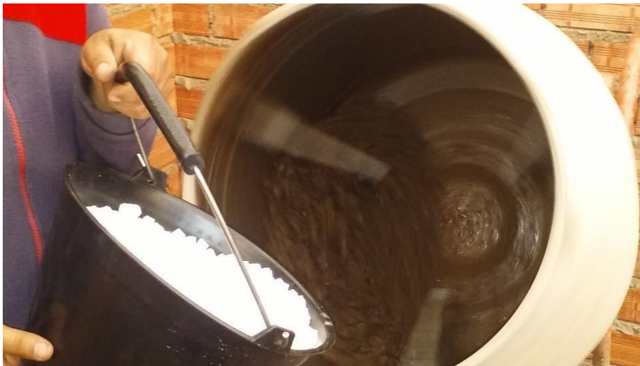
Figura 5. Mezclado del hormigón liviano (Fuente: Autor)
