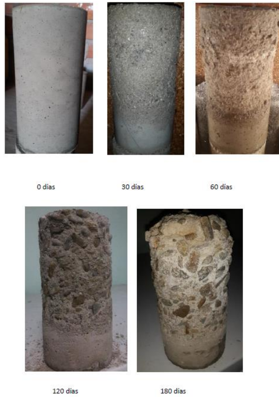
Figura 5. Degradación progresiva de la muestra con relación de a/c 0.45
